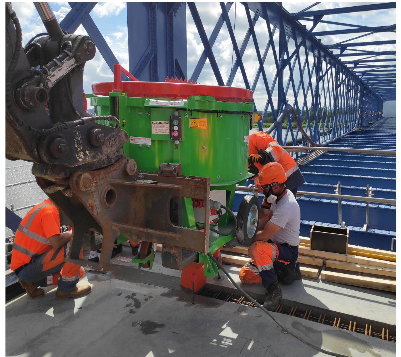
Mauves sur Loire bridge, France, 2020- Bouygues TPRF
