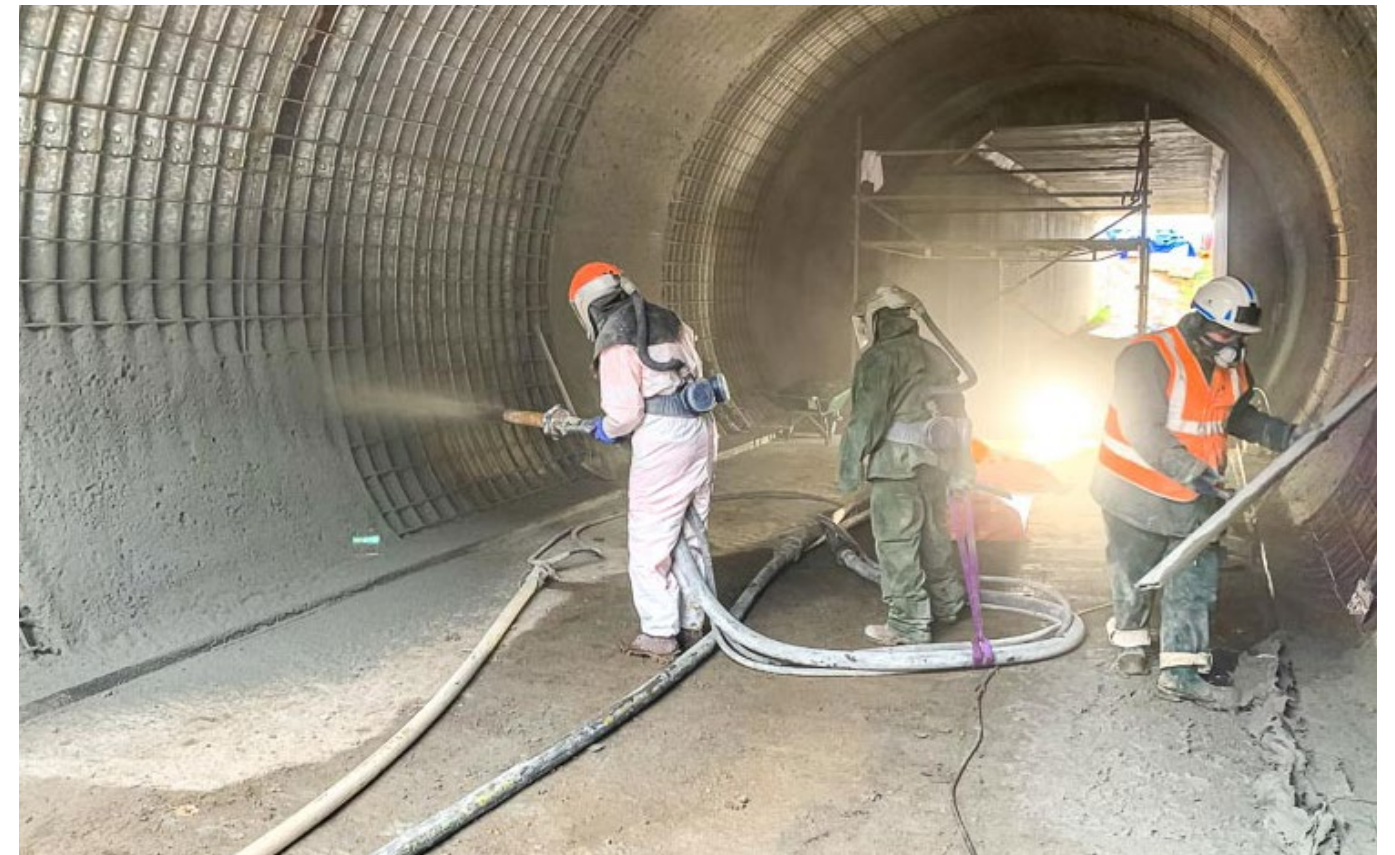
Buse de Barbazan, France, 2020 - Freyssinet
