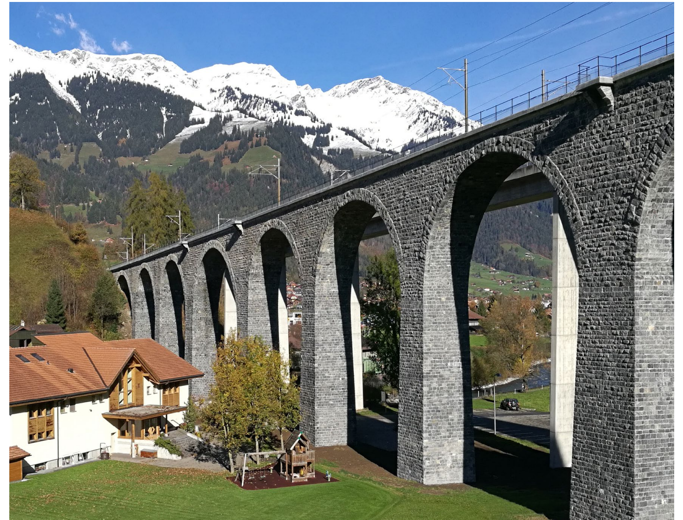
Kanderviadukt, Suisse, 2018 - Walo Bertschinger SA
