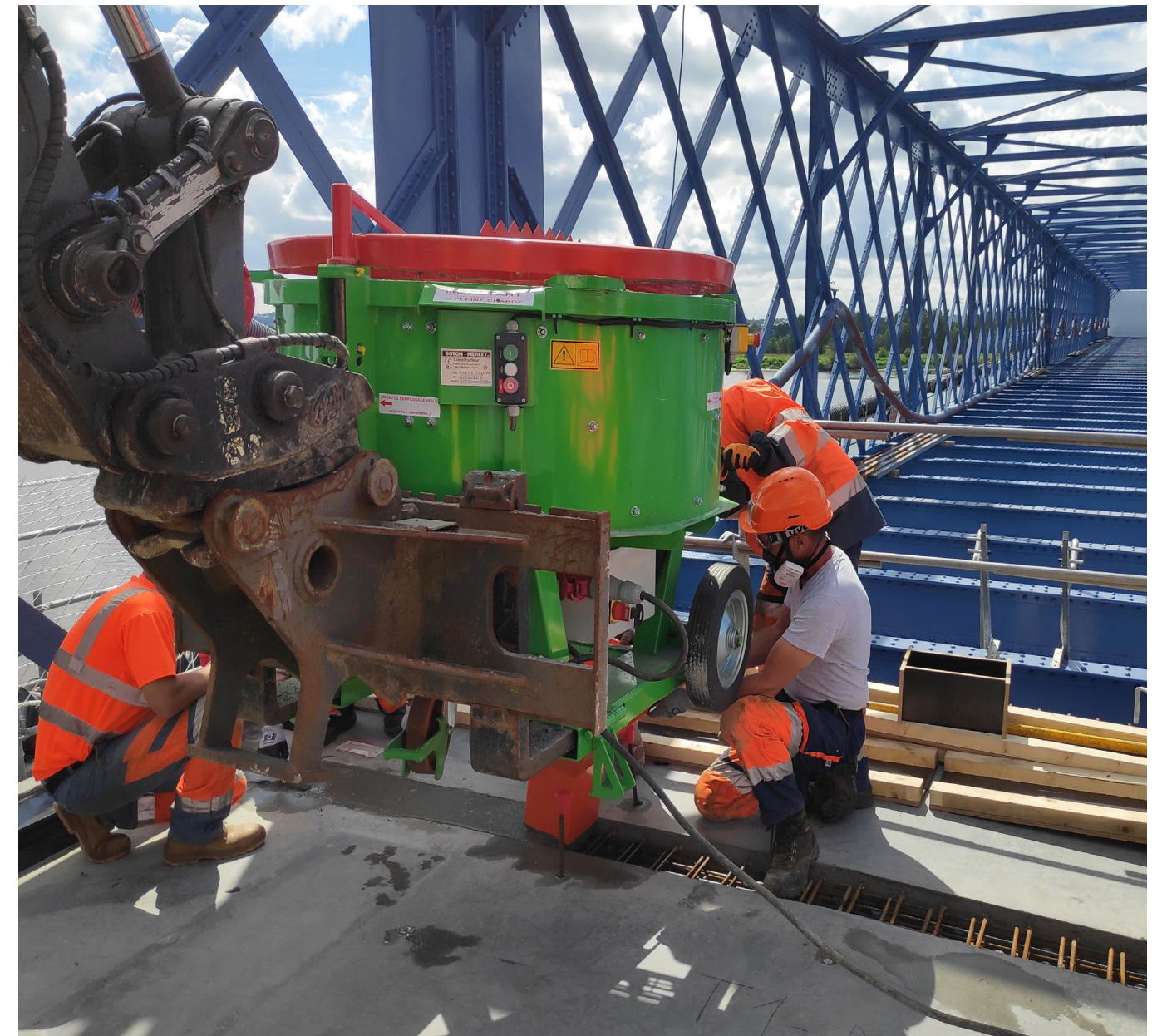
Mauves sur Loire bridge, France, 2020- Bouygues TPRF
